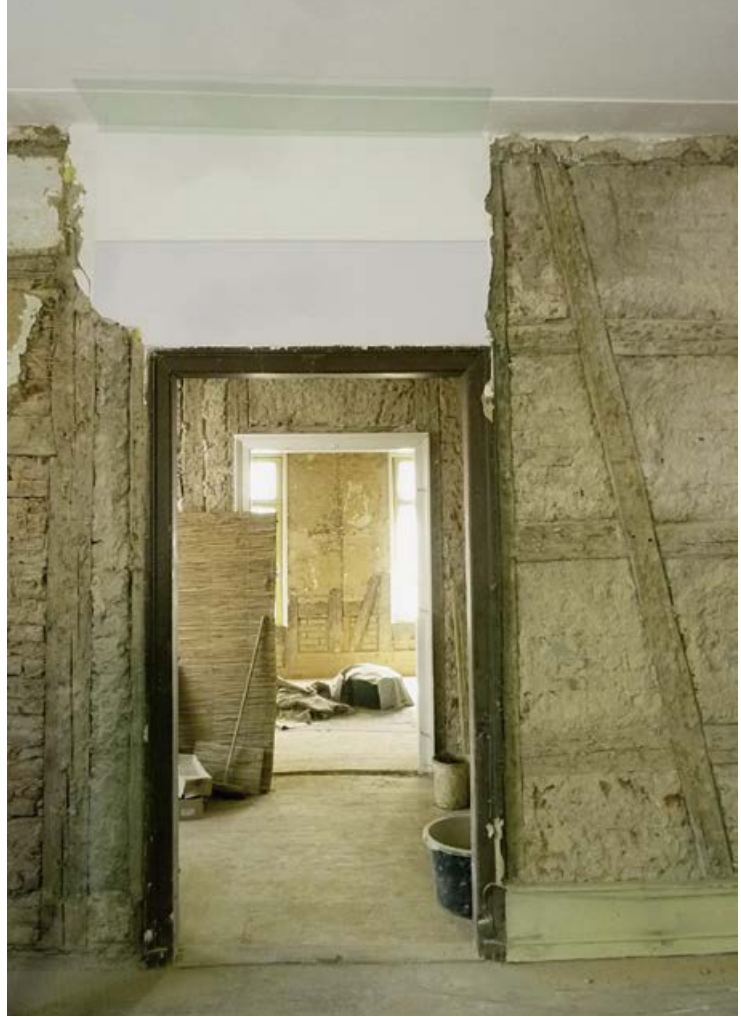
Abb. 13 Fachwerkwände im ersten Obergeschoss, Musterfläche zur Wand- und Deckengestaltung, 2012
