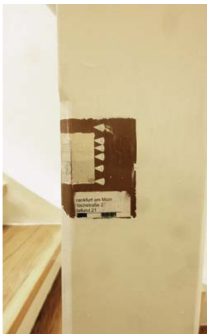
Abb. 11 Treppenhölzer, Befundtreppe, Schichtabfolge – 1 = bauzeitliche Fassung, 2015
