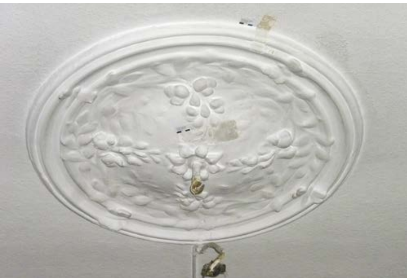
Abb. 15 Stuckrosette, um 1900, Vorzustand, 2012
