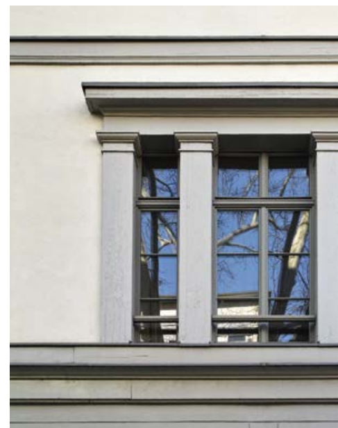
Abb. 6 Ostfassade, erstes Obergeschoss, Fenster, 2014
