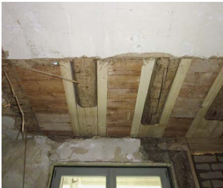
Abb. 7 Deckenbalken-Sanierung, 2011
