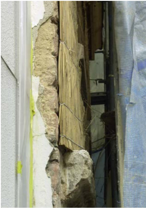
Abb. 12 Fassadendämmung mit Schilfrohrmatten, 2012
